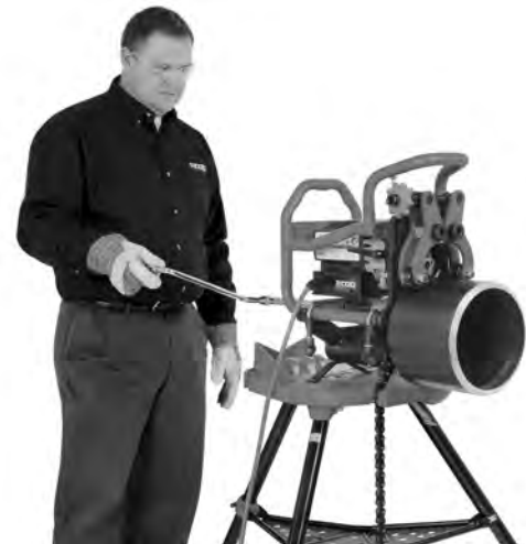
Figure 20C – Biseautage en cours (machine fixe/tuyau mobile)
