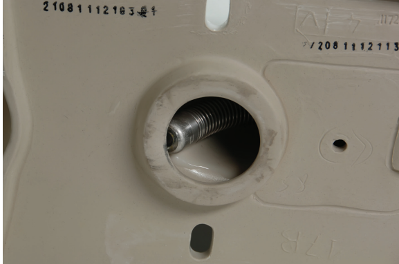
Figür 16 – Kamera Başı Dönüşte Tıkanıp
