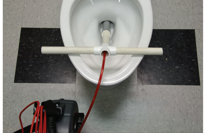
Figür 22 – PVC Kılavuz Borusunu Kullanma
